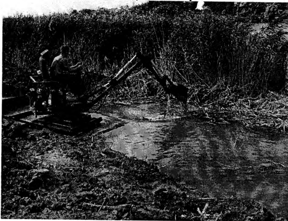
Мала очисна установка в роботі
